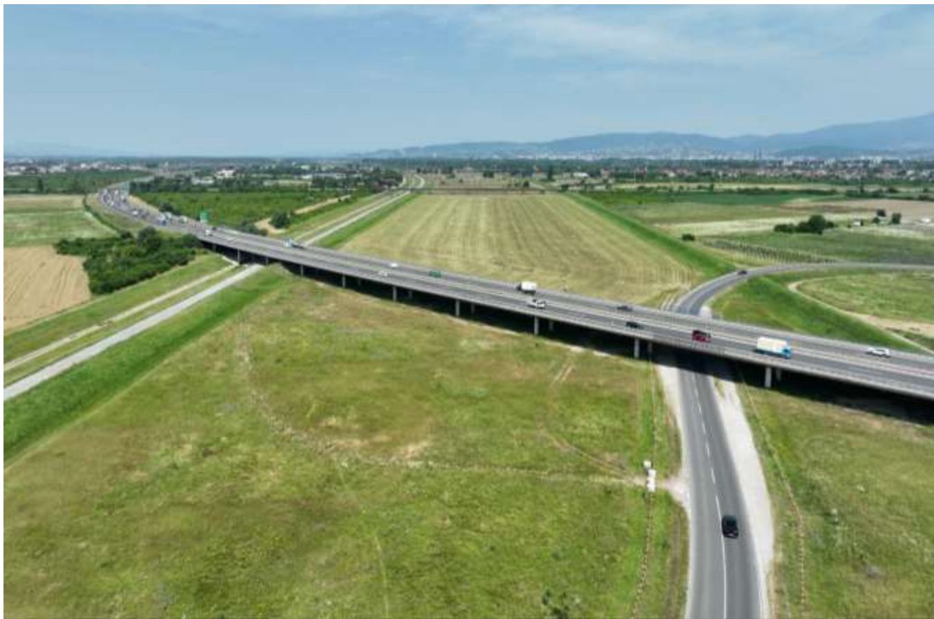
Sl. 97. Pogled na sjevernu dionicu odteretnog kanala Sava–Odra
